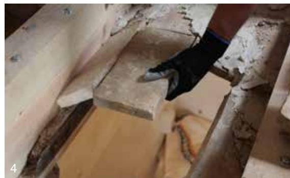
1. Colocación de ladrillo tomado con yeso en una bóveda
