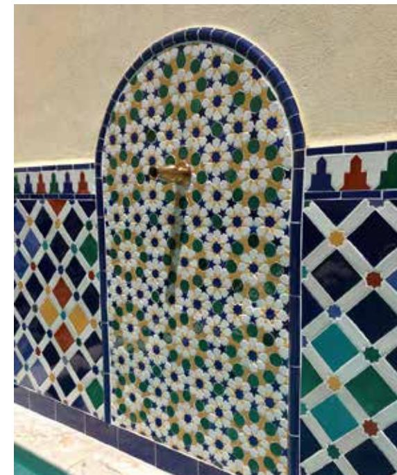
Durante la puesta en obra, los operarios irán creando los dibujos disponiendo las teselas en la posición correcta para la creación del dibujo, tomándolas con mortero. Pasadas 24 horas se procederá al rejuntado del modo ya descrito anteriormente.
